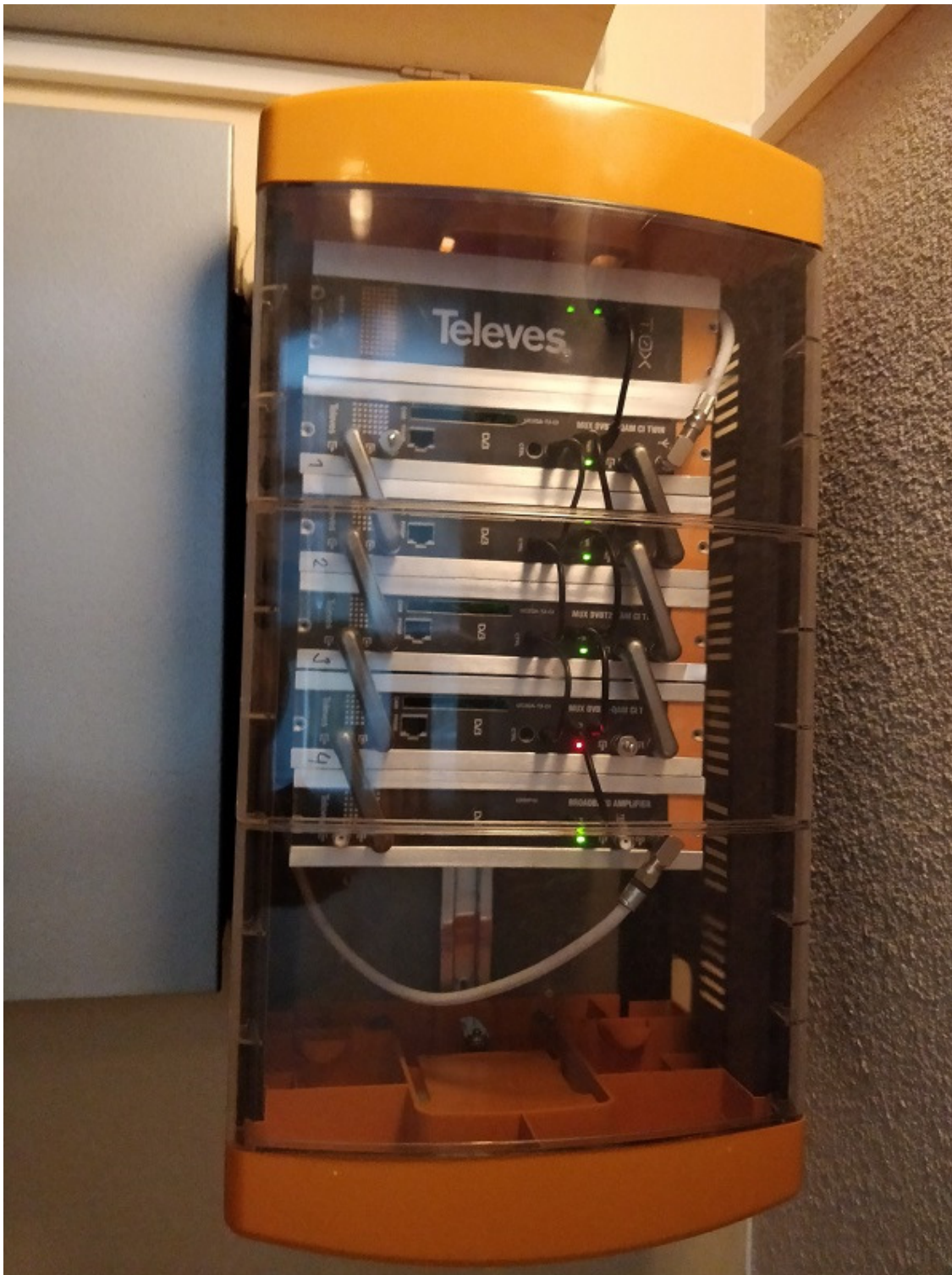
Kuva 1 QAM-laitteisto Säästäjänkatu 9F
